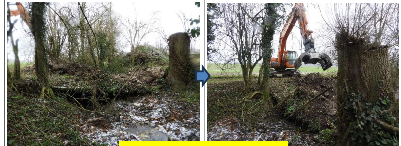
Suppression d'anciennes passerelles
