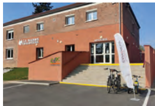
La Maison Forestière Lieu-dit Bois l'Evêque - Ors
