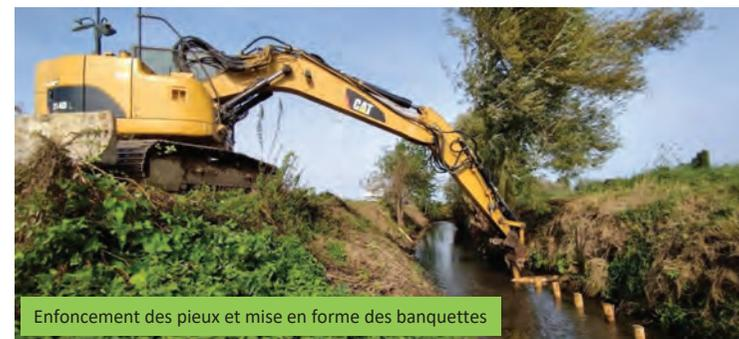
Enfoncement des pieux et mise en forme des banquettes
