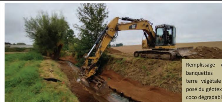
Remplissage des banquettes de terre végétale et pose du géotextile coco dégradable
