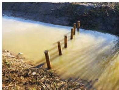
Le piège à embâcle réalisé à Maretz est efficace. Il protège le pont plus en aval.
